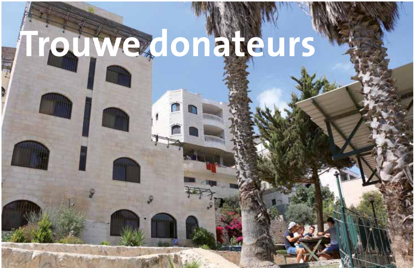
Er zijn plannen om het achterstallig onderhoud in de gebouwen van Jemima aan te pakken.
